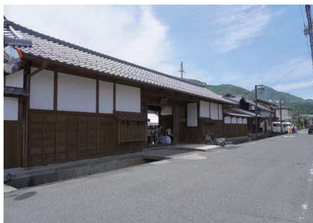
復原修理を終えた大溝陣屋総門
