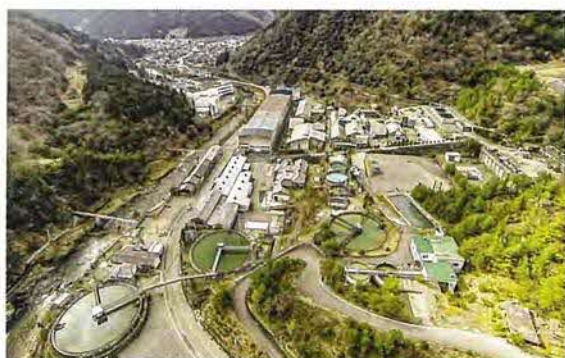
生野鉱山本部。明治時代の施設が現役で稼働している。
