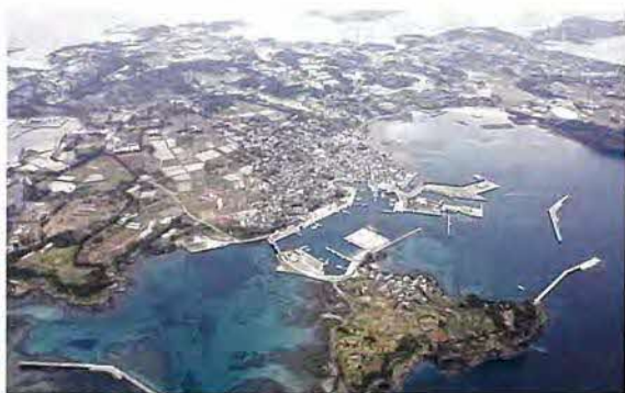
小値賀島の遠景（南側より）
