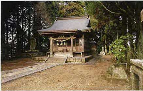
竣工後の布田神社本殿
