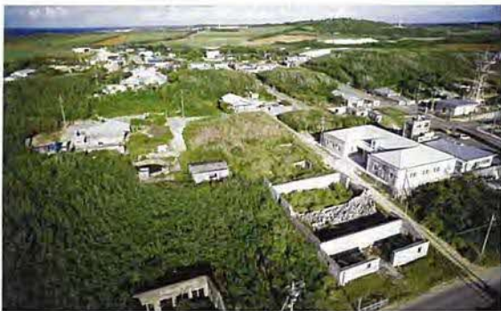
集落中心部（東から）当時から整然とした街区だった
