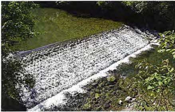
石積の頭首工
