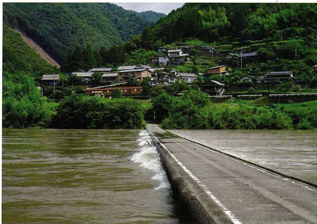
増水時の岩間沈下橋
