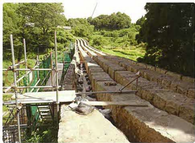
通水石管の検出状況
