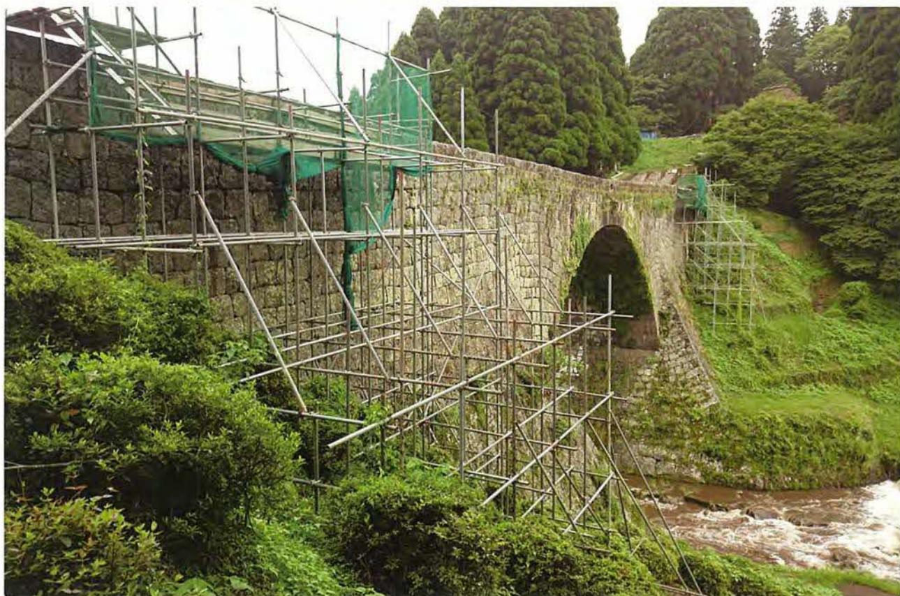
保存修理工事中の通潤橋
