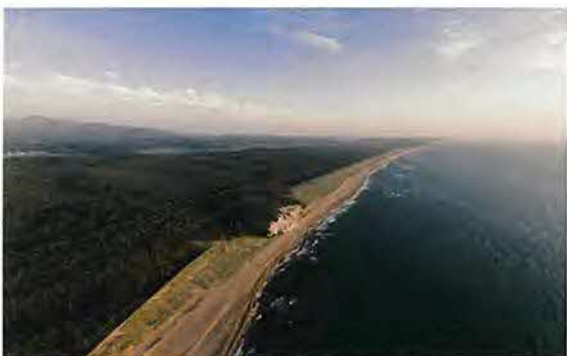
上空からみた加賀海岸地域の海岸砂防林
