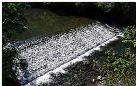
石積の頭首工
