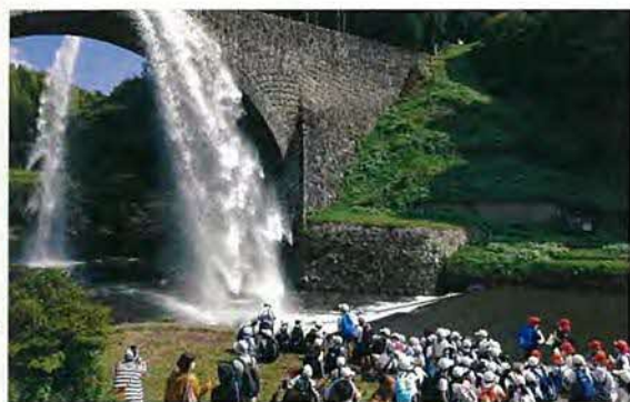
通潤橋の放水と見学する小学生
