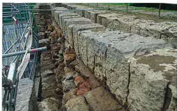
保存修理工事中の通潤橋（令和元年7月）右岸上流側石垣の内部構造
