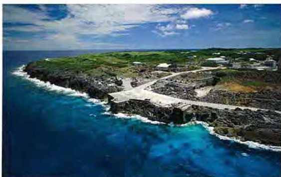
北東部の港と集落(西から) 中央 史跡 北大東島燐鉱山遺跡燐鉱石貯蔵庫跡
