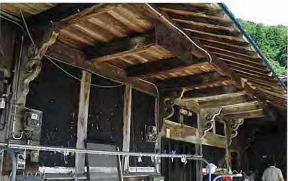
冬場の作業空間「カイドレ」と軒を支える「持ち送り」
