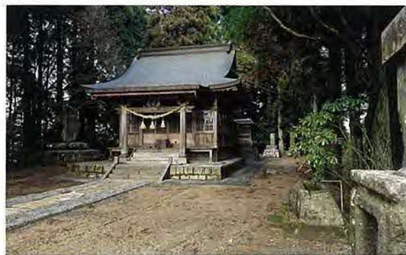
竣工後の布田神社本殿
