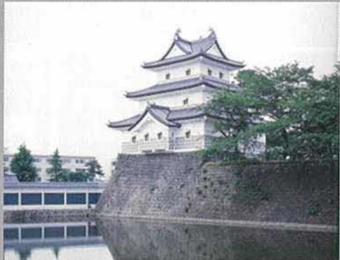
新潟県新潟市 新発田城三階櫓 復元工事設計監理
