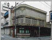
埼玉県秩父市 小池タバコ店 歴史的建造物調査・登録文化財調査
