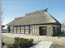
新潟県新潟市 旧武田家住宅 解体復原工事設計監理
