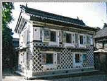
新潟県長岡市 機関73号酒製造本舗 土蔵修復工事 指導・助言
