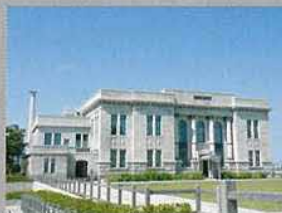
新潟県新潟市 旧第四銀行住吉町支店 移築復原工事設計監理
