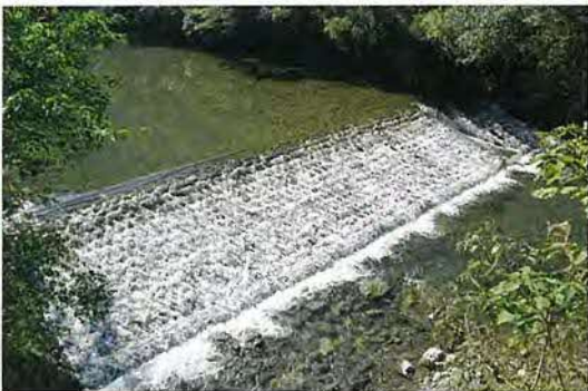
石積の頭首工
