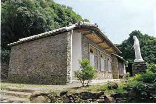
玄武岩を用いた「ド・口壁※」で造られた大野教会堂 ※藁すさに代わり赤土に石灰を混ぜる練積み
