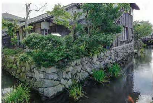
周囲を水路に囲まれた岸建ち建物
