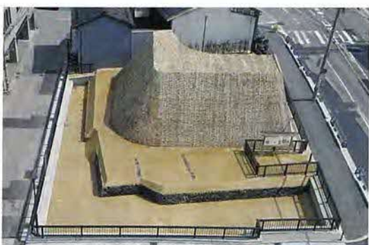
西外惣構跡（升形地点）復元整備（平成30年3月完成）
