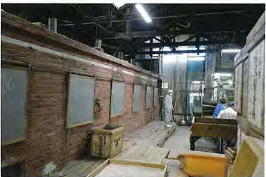
大正期の煉瓦製碾茶乾燥炉が稼働する製茶場
