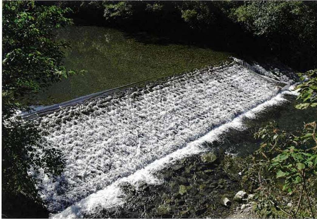
石積の頭首工
