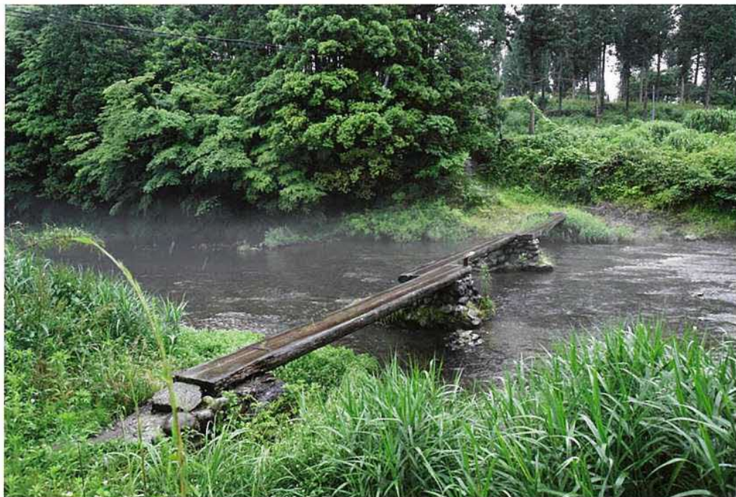
早瀬の一本橋 流れ橋と言われ、沈下橋の原型とされる
