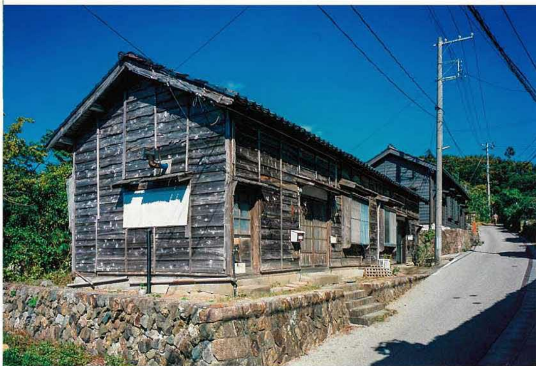
相川上町の旧鉱山住宅
