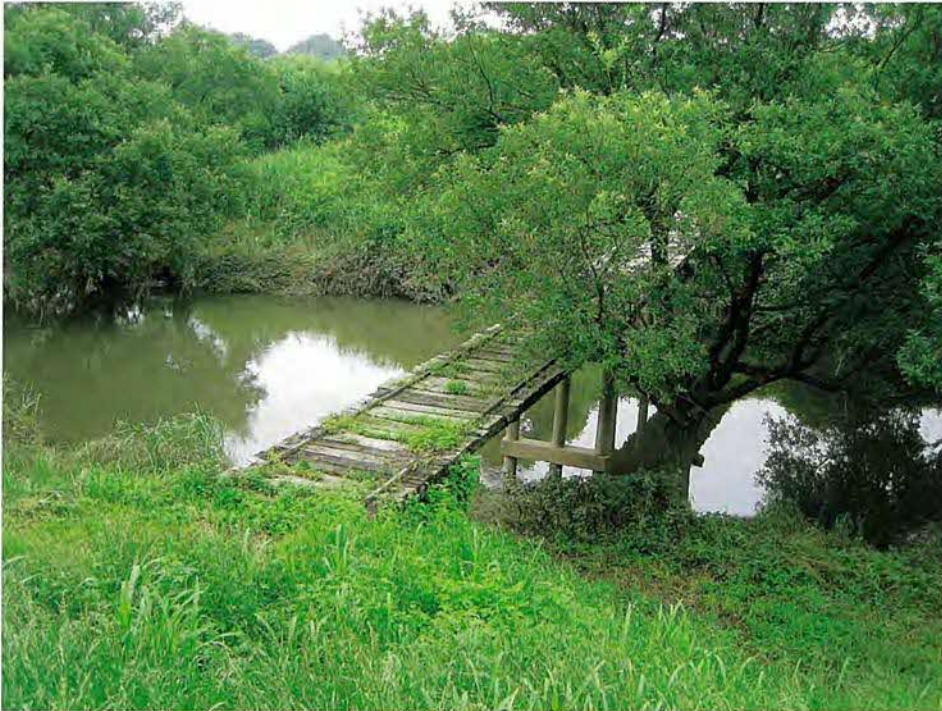
通り前橋 谷田川に架かる沈下橋
