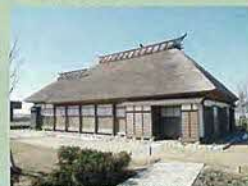
■新潟県新潟市 旧武田家住宅 解体復原工事設計監理 新潟市指定文化財
