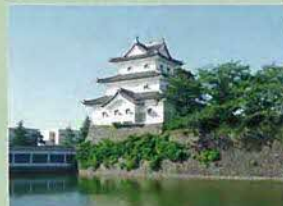
■新潟県新潟市 新発田城三層櫓 復元工事設計監理 新発田市指定史跡
