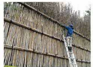
1 間垣の維持補修作業 毎年古くなったニガタケを抜き、新しいものを補充する。
