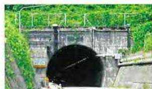
1 北陸線旧クリカラトンネル
