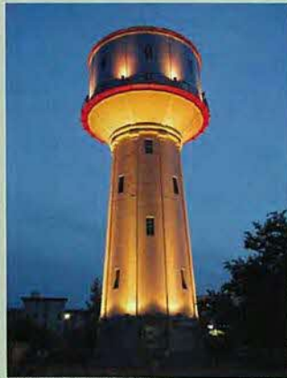
■新潟県長岡市 中島配水塔 修繕工事設計監理 国登録有形文化財
