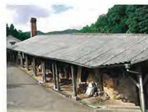
4 登り窯 昼夜丸2日の焼成から、小鹿田焼が完成、年6回程度の窯出し。
