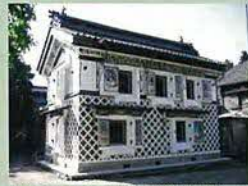
■新潟県長岡市 機部ワシ酒製造本舗 土蔵修復工事 指導・助言 国登録有形文化財
