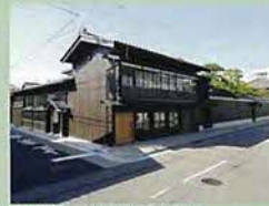
■新潟県新潟市 旧小澤家住宅 整備工事設計監理 新潟市指定文化財
