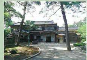
■新潟県柏崎市 飯塚邸 修復工事設計監理 柏崎市指定史跡
