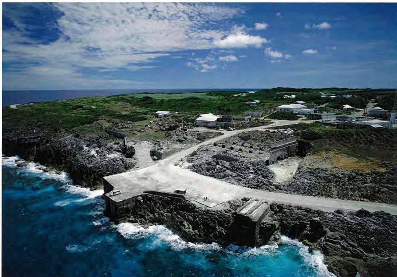
西港一带に広がる燐鉱生産施設群
