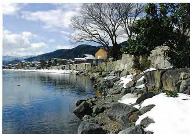
海津・西浜の石積み 部分的な修復を繰り返しながら守られてきた海津・西浜の石積み
