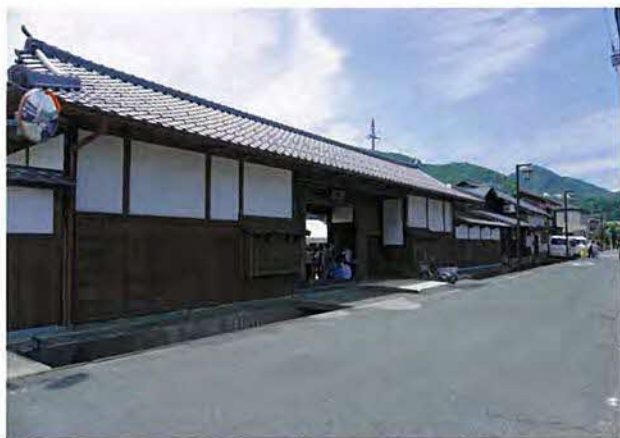
復原修理を終えた大溝陣屋総門
