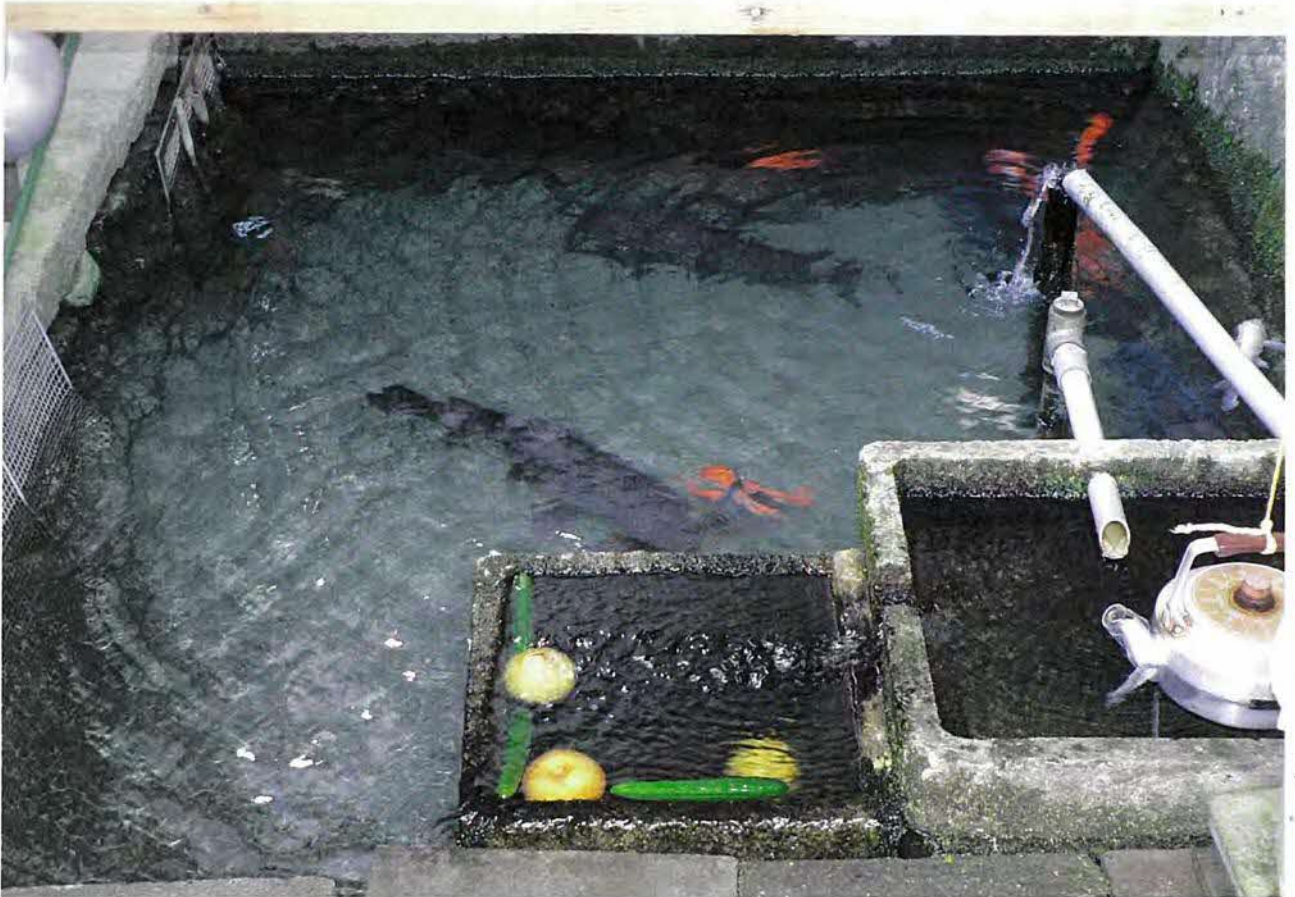
針江のカバタ カバタの仕組みは湧水が「元池」から「壺池」、「端池」を経て水路へと流れるようになっている
